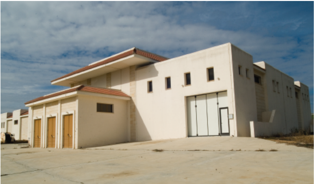
Υποσταθμός Μεταφοράς 132kV Κλειστού Τύπου «Παπακώστας»
